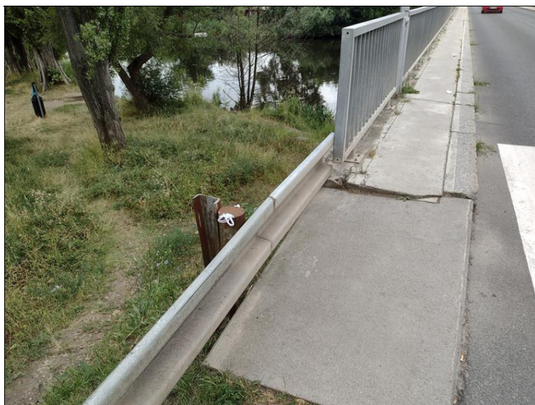
Napojení svodidla na zábradlí u OP1 vlevo
