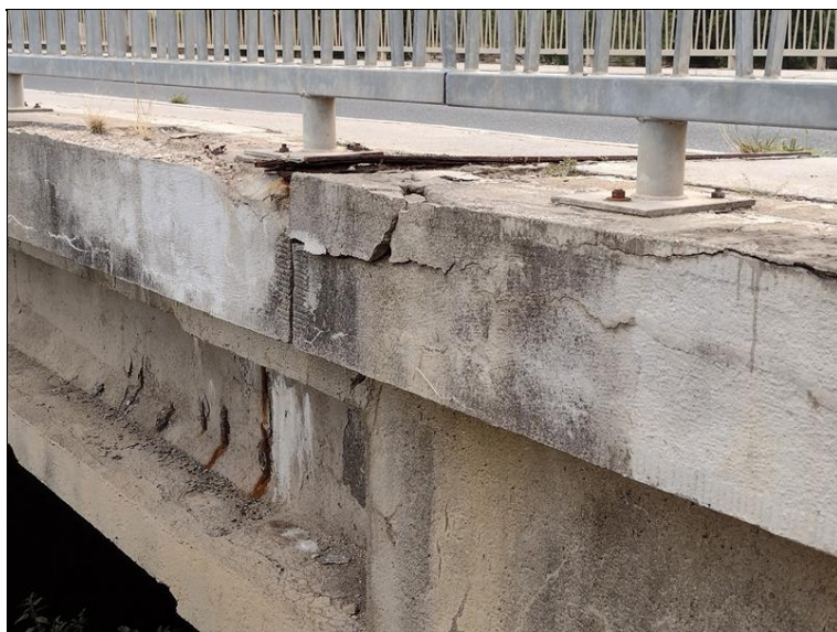
Degradace římsy
