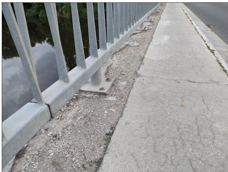
Degradace římsy
