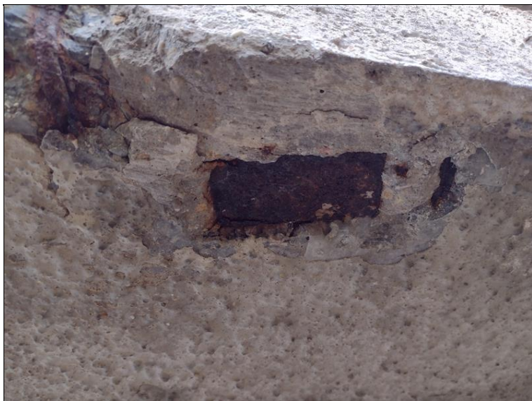
Kotva příčného předpětí
