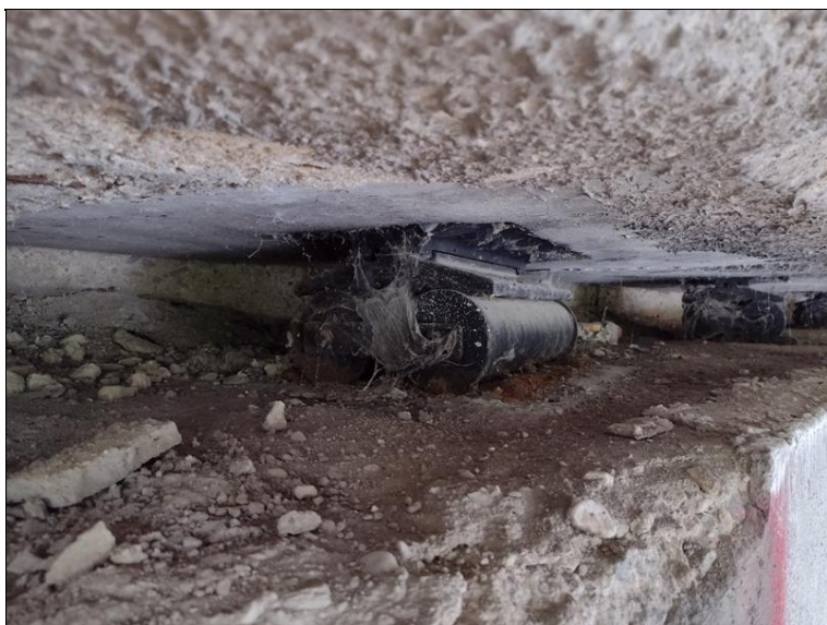
Válcové ložisko na OP4
