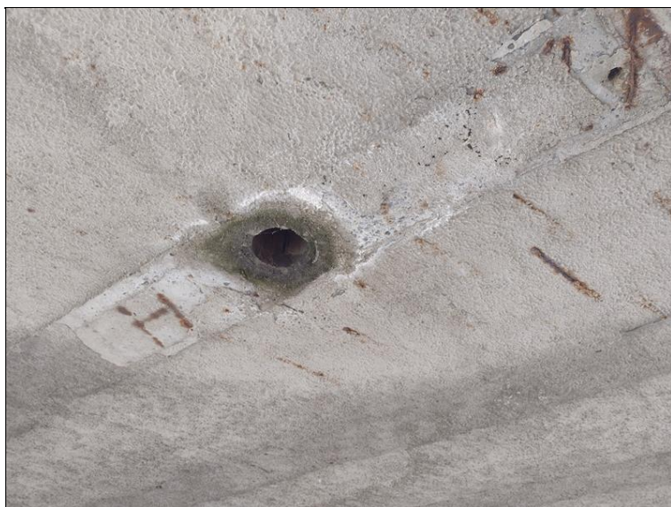
Svislý svod odvodnění na podhledu nepřesahuje přes obrys podhledu a tím dochází k zmáčení podhledu
