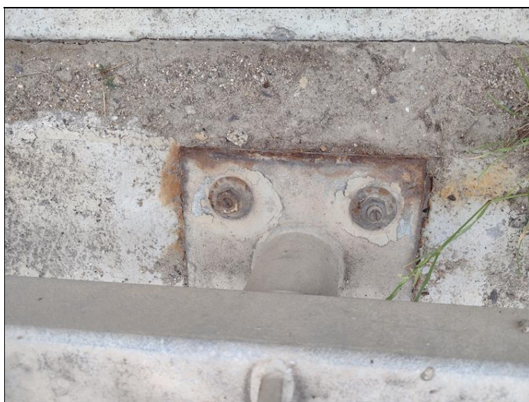
koroze kotvení zábradlí
