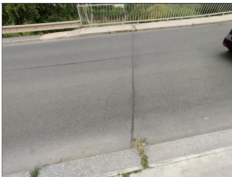
Dilatační spára ve vozovce u OP4
