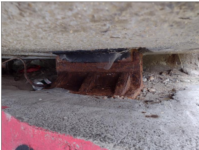
Pevné ložisko na OP1
