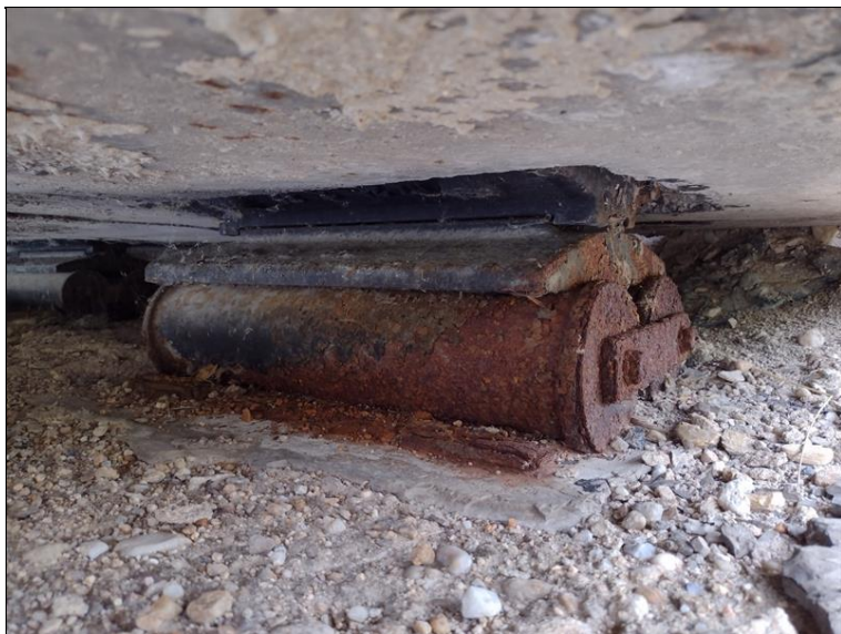
Válcové ložisko na OP4
