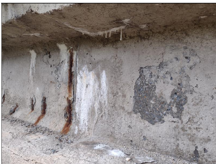
Stopy po zatékání na boku NK - pravé strana u OP4
