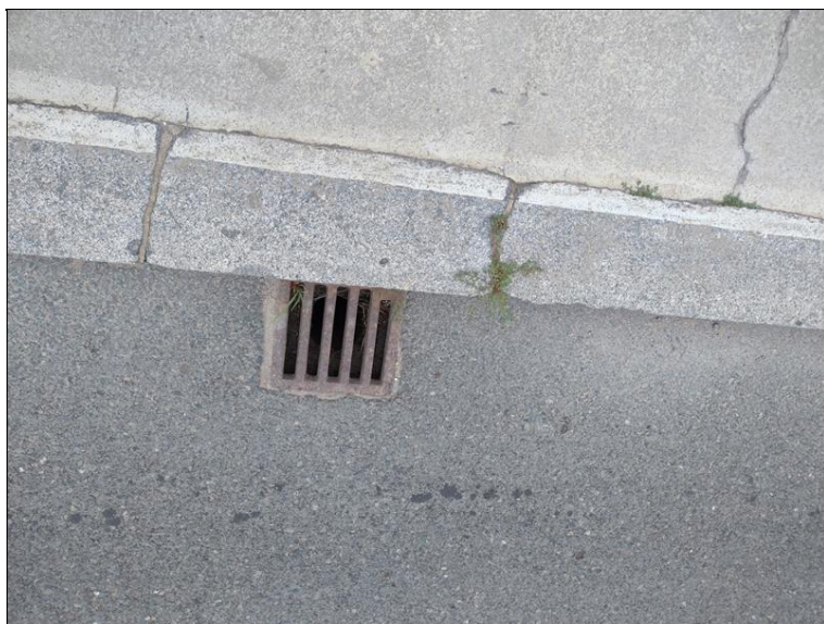
Odvodňovač ve vozovce
