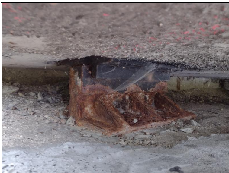
Pevné ložisko na OP1
