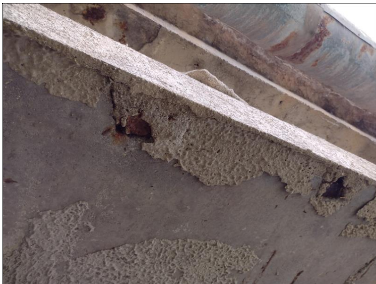
Torkretová omítka se celoplošně loupe
