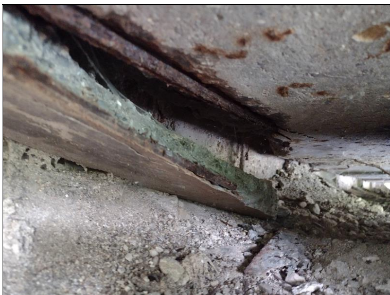
Oddpadlá krycí vrstva za ložiskem u krajního levého nosníku u OP4
